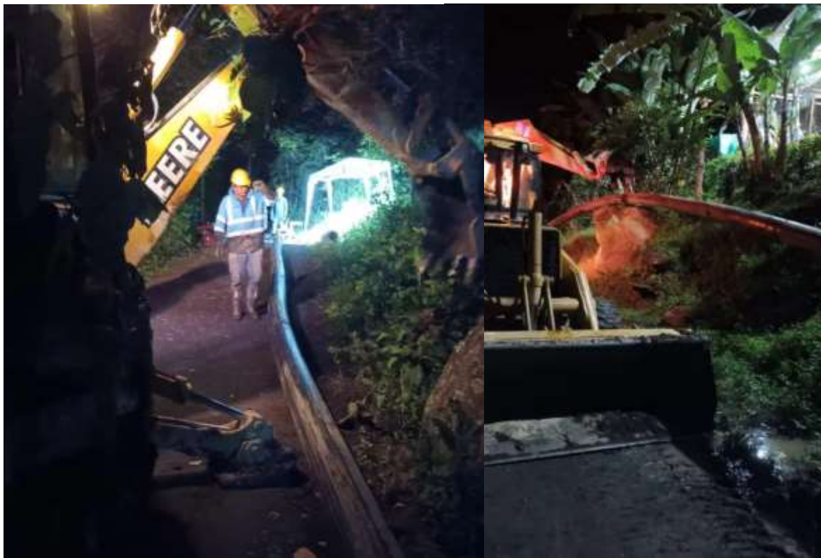
Proceso de instalación de tubería Polietileno de Alta Densidad en nuevo trazado por vía pública.
