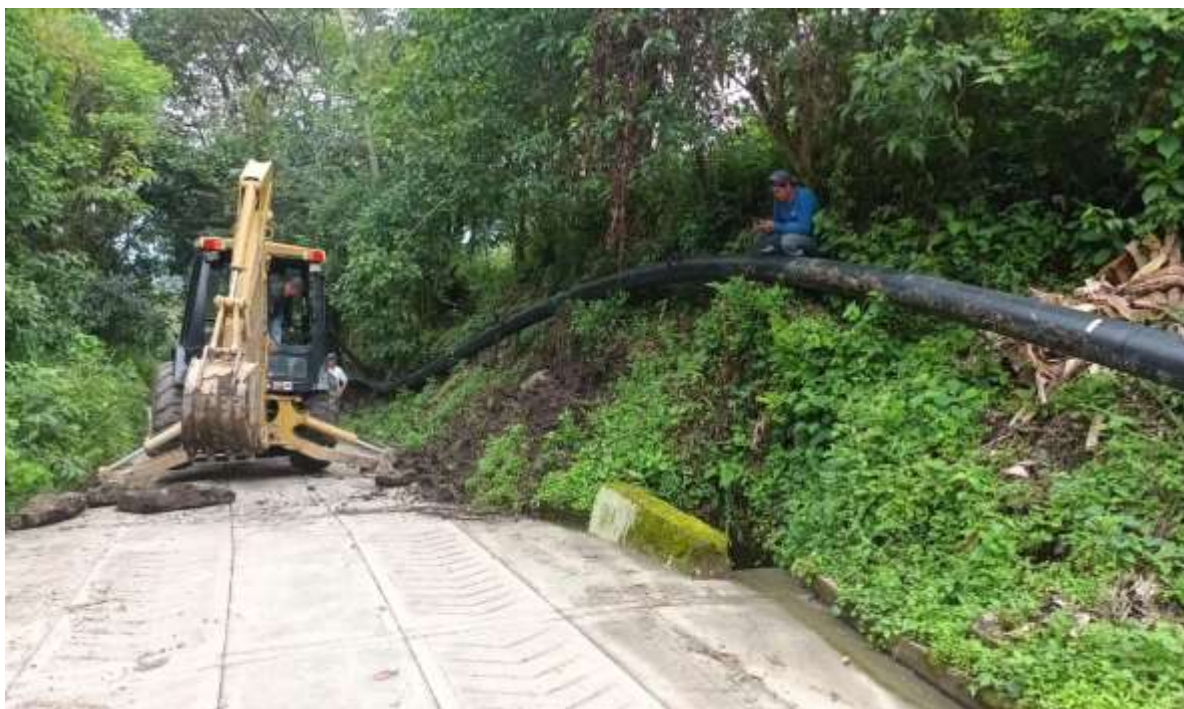
Proceso de instalación de tubería Polietileno de Alta Densidad en nuevo trazado por vía pública.
