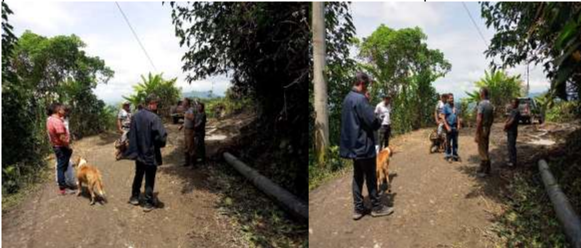
Proceso de unión de tubería de polietileno de alta densidad, con técnica y equipos de termofusión a tope:
