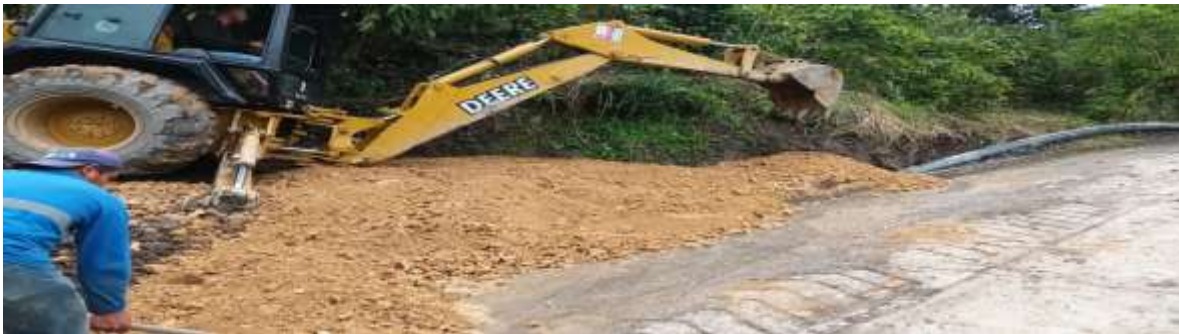
Proceso de restitucion de accesos a las entradas de los predios por donde se instaló el tramo en via publica
