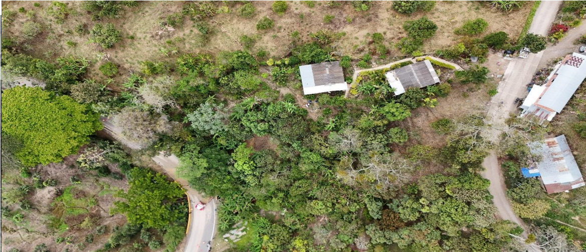
Red de aducción en masa (FRM) Tena, Cundinamarca, Colombia Cra. 8 # 2b-15, Tena, Cundinamarca 252610, Colombia Lat 4.655742° Long -74.393567° viernes, 21/11/2025 04:13 p. m. GMT -05:00
